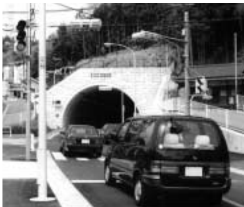
信号機が設置された新小峰トンネル
