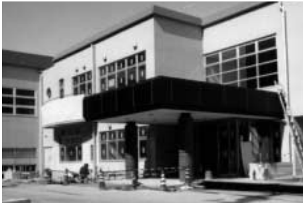
完成間近の加住市民センター
