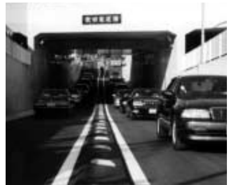
昨年11月に開通した散田架道橋
