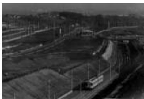
▲造成中のめじろ台団地(昭和43年頃)
