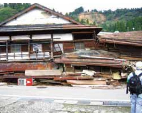
倒壊による被害を防ぐために（新潟県中越地震で）
