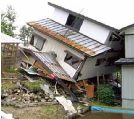
震災で崩壊した家屋(新潟県中越地震で)
