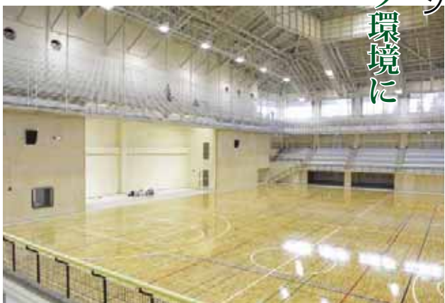
▲運営再開に向けて工事中
