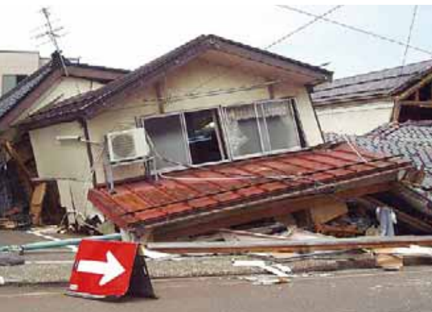
▲震災で崩壊した家屋
