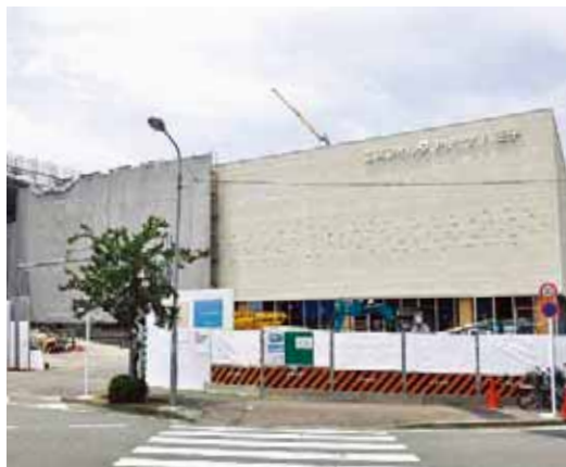
▲10月の開館に向けて建設が進む狭間町の総合体育館「エスフォルタアリーナ八王子」
