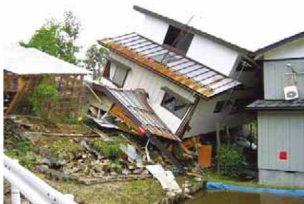
▲倒壊した木造住宅(新潟県中越沖地震で)
