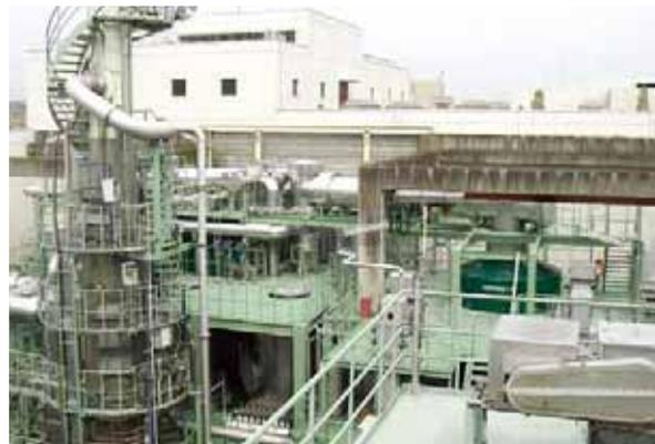
▲ターボ型流動焼却炉が導入された浅川水再生センター
