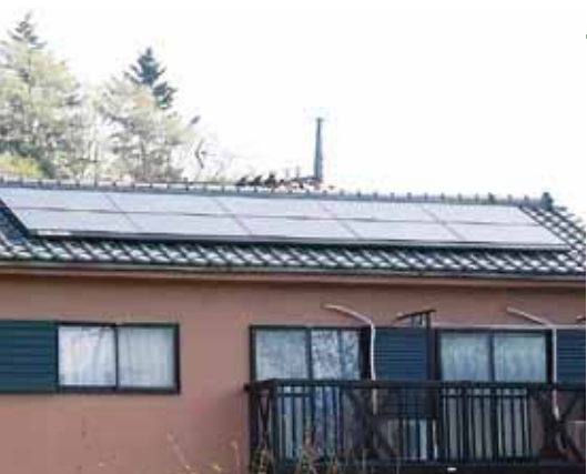
▲ソーラーパネルの設置で光熱費の削減にも
