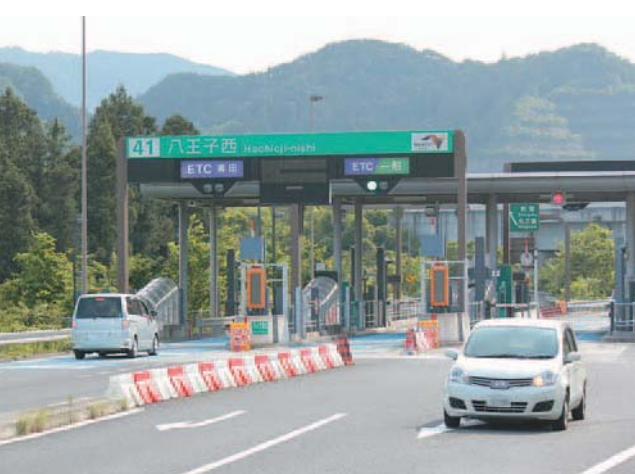
▲八王子西インターのフル機能化に向け調査を実施
