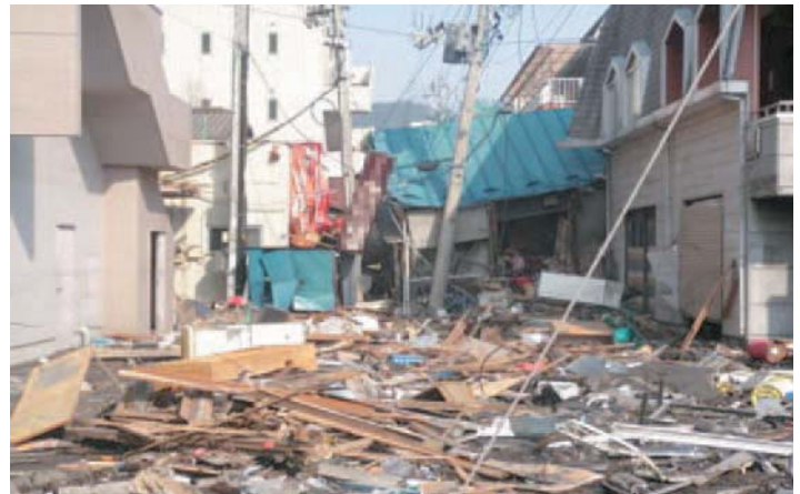
▲東日本大震災でも倒壊した建物が道路を塞いだ事例が発生
