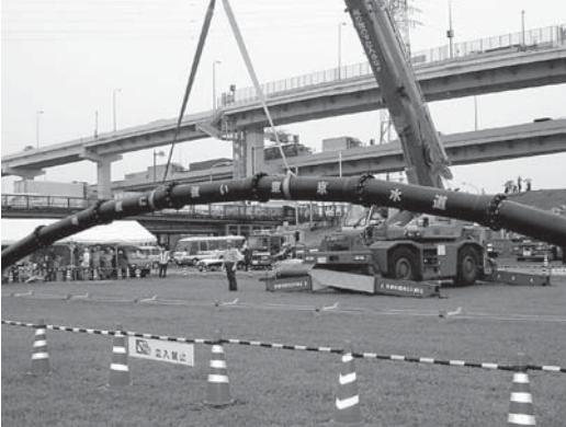
▲抜け出し防止機能を備えた水道管(写真提供:都水道局)
