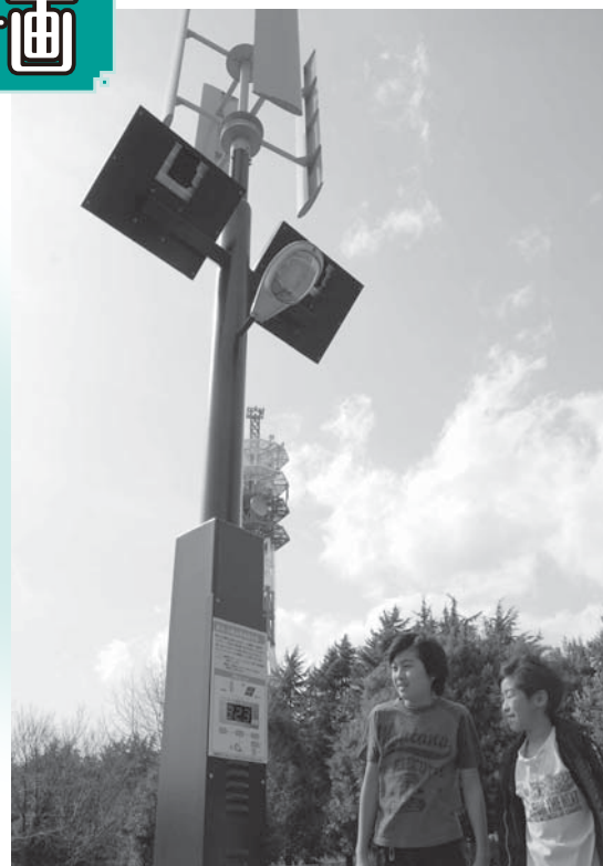
◀風力と太陽光で発電する装置を設置(あったかホール)
