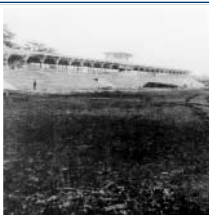
建設中の高倉町の競馬場のメインスタンド
