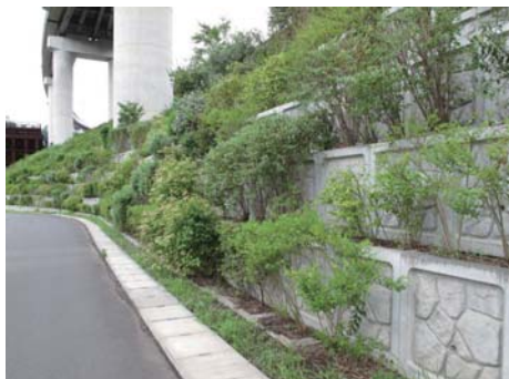
擁壁を自然石風に仕上げ、段状にして植栽を配置することで、自然の傾斜地との調和を図っている例（八王子市）
