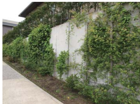
擁壁の前に植栽帯を設け、ツタ類等で緑化して圧迫感の軽減をしている例（横須賀市）
