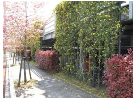
(右) 立体駐車場の周りを樹木やツタ類で変化を付けながら緑化し、歩行者空間を演出している例（倉敷市）
