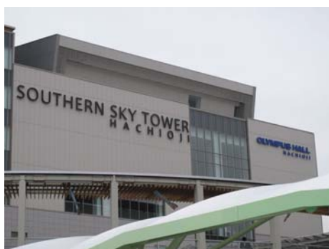
建築物のデザインと調和させた屋外広告物の例 (中心市街地環境整備地区)
