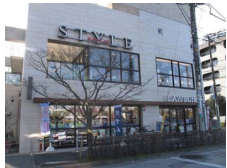
建物の意匠との調和を図り、屋外広告物の大きさや色彩などを工夫した例（世田谷区）
