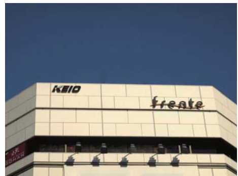
屋上設備の修景用の壁面を利用し、屋外広告物を建物の意匠と調和させた例（新宿区）
