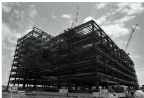
昭和56 年、浅川沿いでは、現在の市役所本庁舎建設が進められていた
