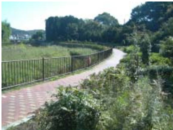
整備が進んでいる川口川
