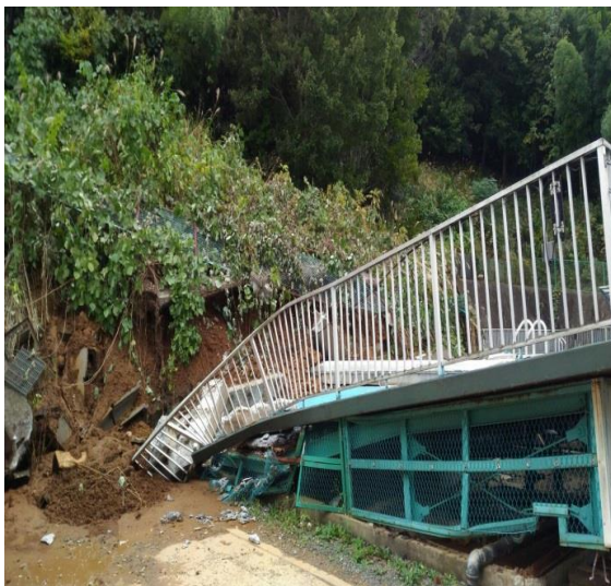
▲加住小学校の土砂崩れ状況（左：プールの損壊、右：給食室へ土砂の流入）
