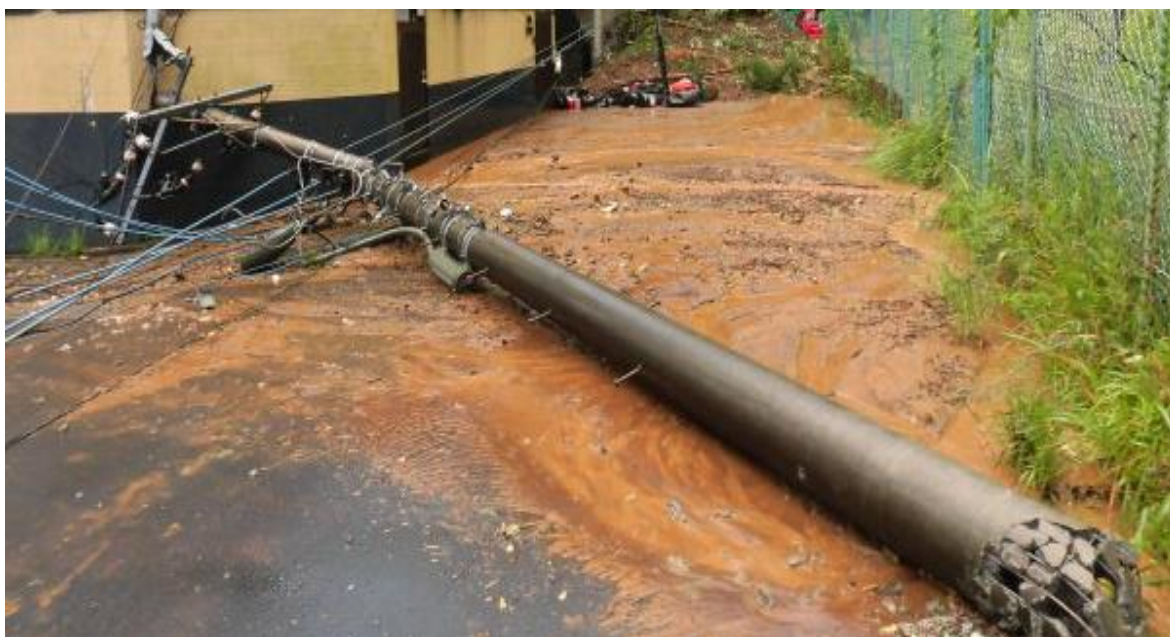
▲土砂崩れにより倒壊した電柱 ※東京電力パワーグリッド（株）提供
