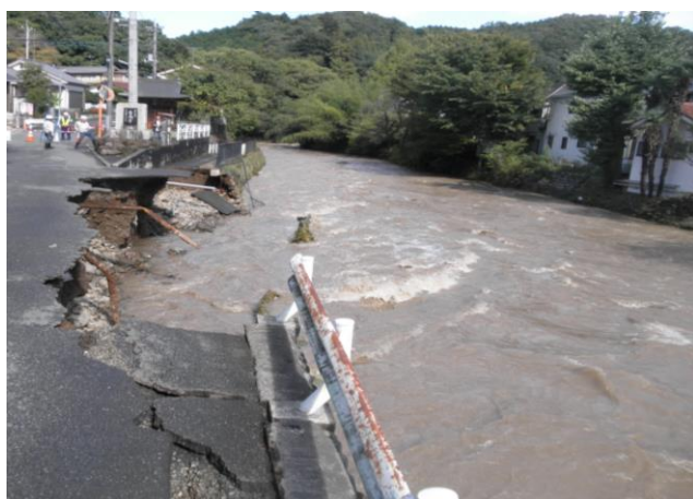
▲南浅川護岸崩落（西浅川町）
