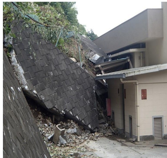
▲加住小学校の土砂崩れ状況（左：プールの損壊、右：給食室へ土砂の流入）
