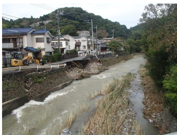
▲南浅川護岸崩落（西浅川町）
