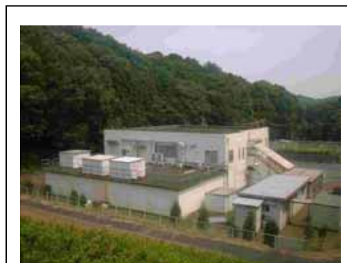
最終処分場浸出水処理施設
