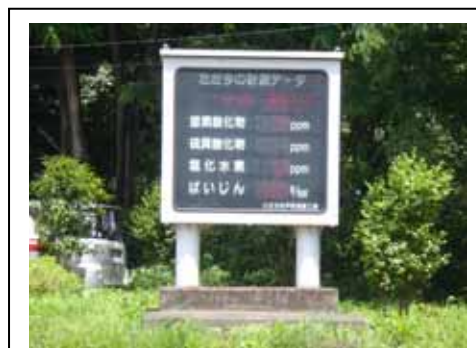
排ガス状況表示盤
