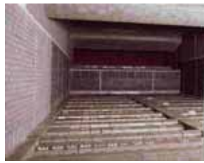
焼却炉の内部
