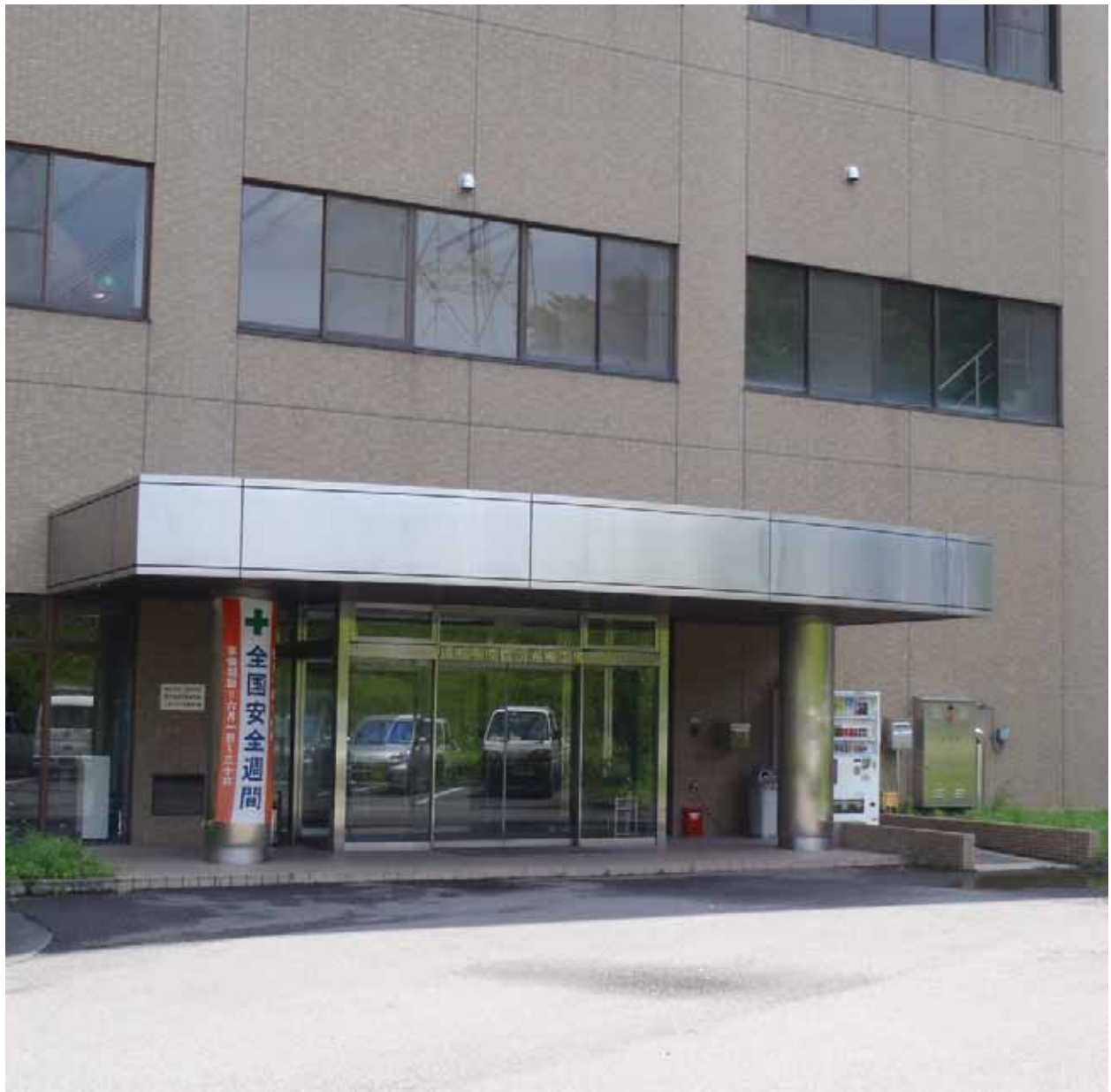
工場棟正面玄関
