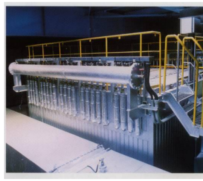
ろ過式集じん機 排ガス中のばいじんやダイオキシン類を、ろ過式集じん機（バグフィルター）によって微細なばいじんまで除去します。
