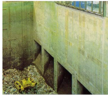
ごみピット及びごみクレーン
