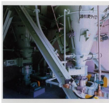
乾式有害ガス除去装置 ごみの燃焼によって発生する有害ガスを薬品で除去します。
