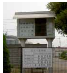
排ガス状況表示盤
