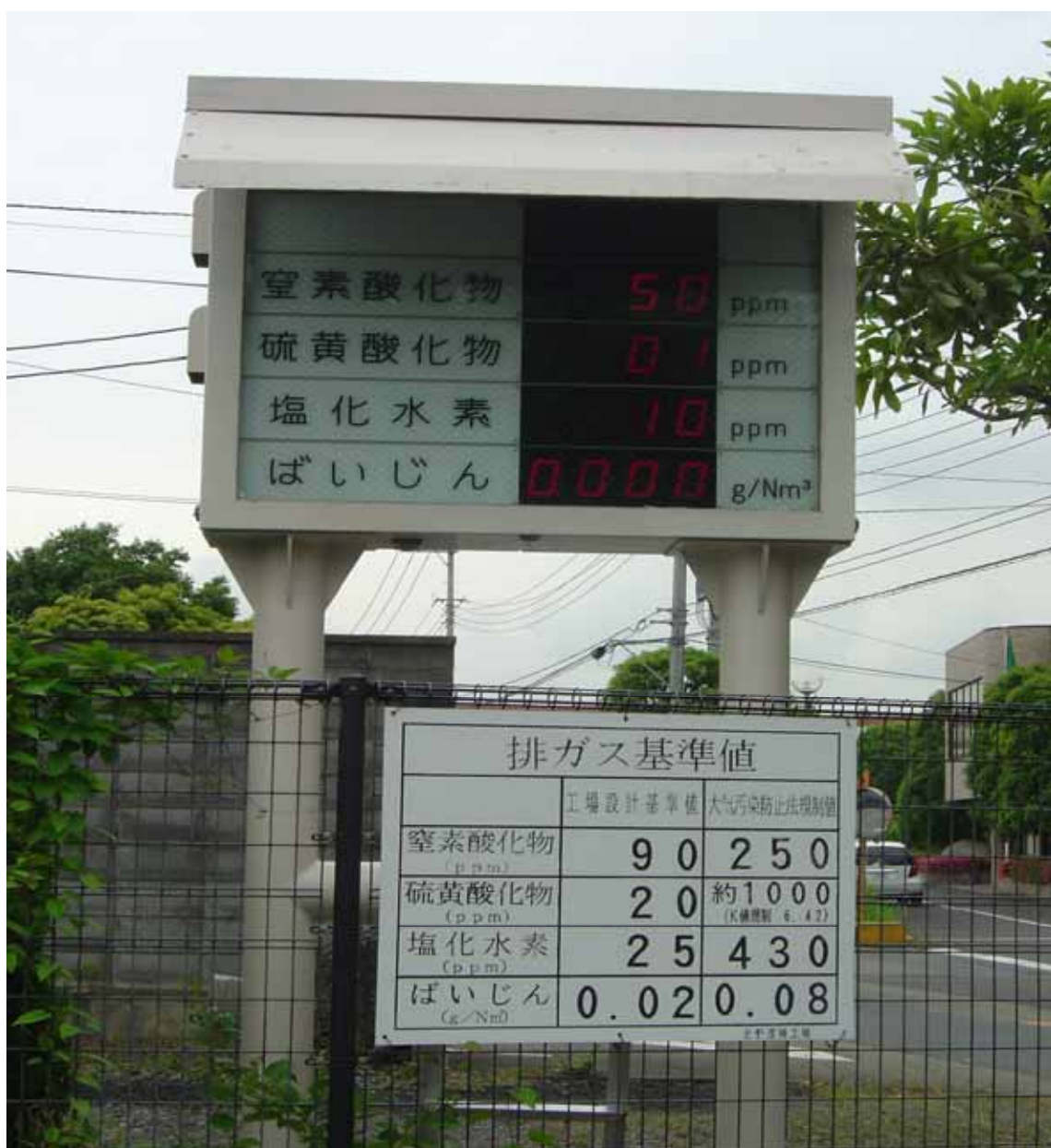
「排ガス状況表示盤」
