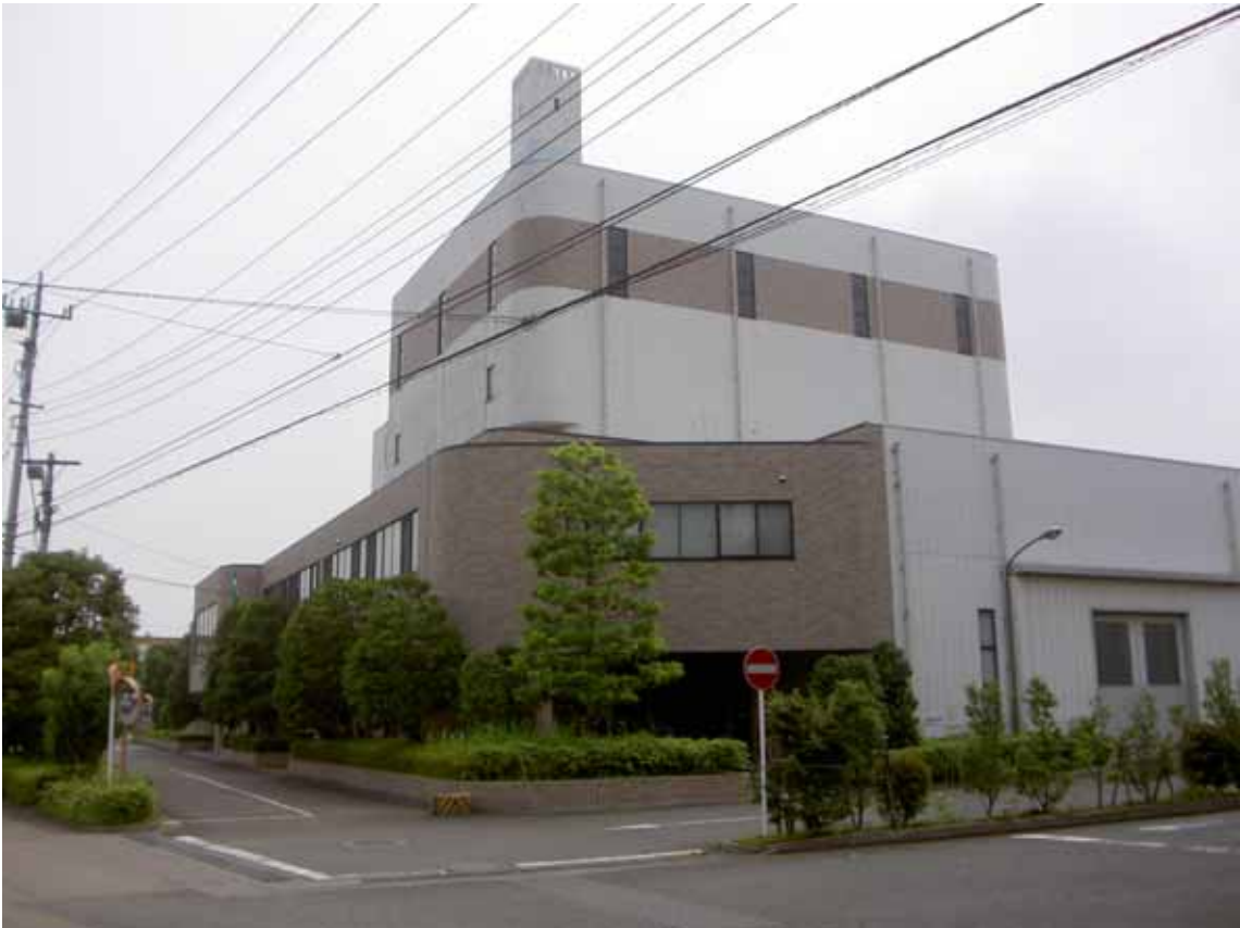
「北野清掃工場棟」
