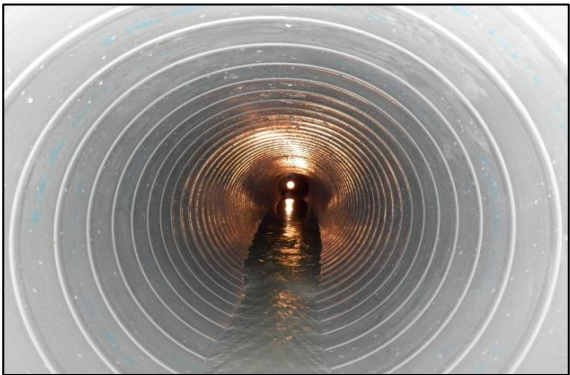
管の更生による不明水の止水
