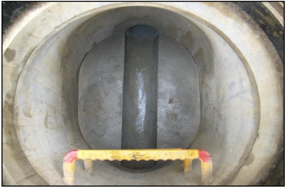
マンホールの更新による不明水の止水
