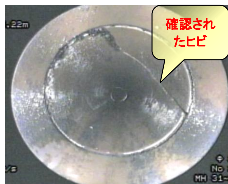
下水道管内の調査によって、異常を早期に発見し対策することで事故の未然防止につながります
