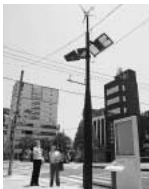
▶ビルが立ち並び、日が当たりにくい地区から注目されている、風力も使った街路灯
