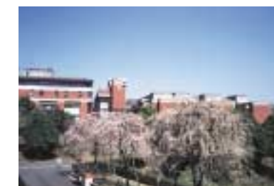
東京薬科大学(堀之内)昭和51年開設。自然に囲まれたレンガ造りの校舎と薬用植物園、自然池などがある。
