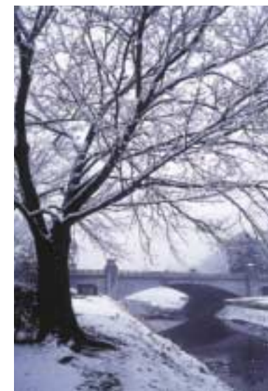
南浅川橋(長房町など)南浅川にかかり、多摩御陵(武蔵陵墓地)への参道となっている。昭和11年に架橋。
