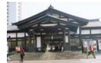
高尾駅駅舎(高尾町)全国的にも珍しい木造の駅舎。高尾山の表玄関として、年間を通して観光客でにぎわう。
