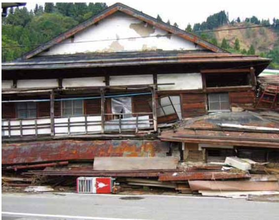
▲倒壊した住宅(阪神・淡路大震災で)
