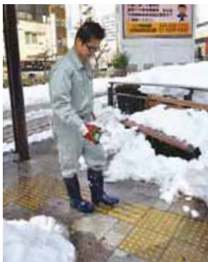
▲凍結防止のために塩化カルシウムを散布
