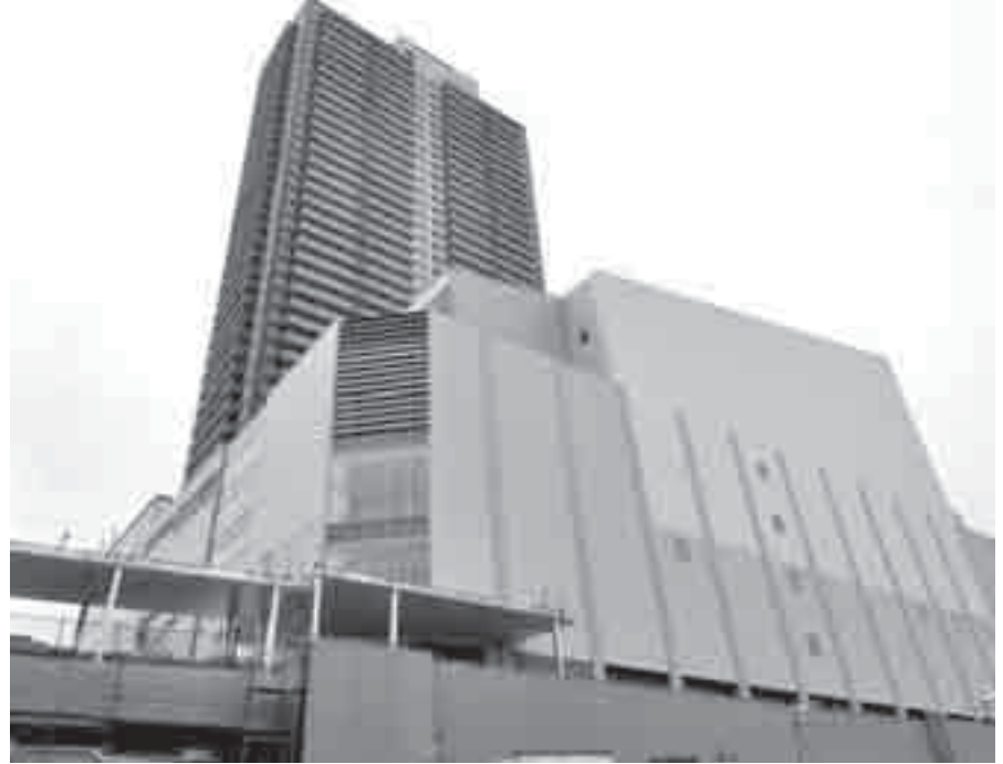
▲着々と工事が進む「サザンスカイトワー八王子」 (手前が新市民会館)
