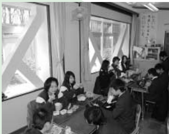
▲窓に沿って耐震補強された教室で安全に
