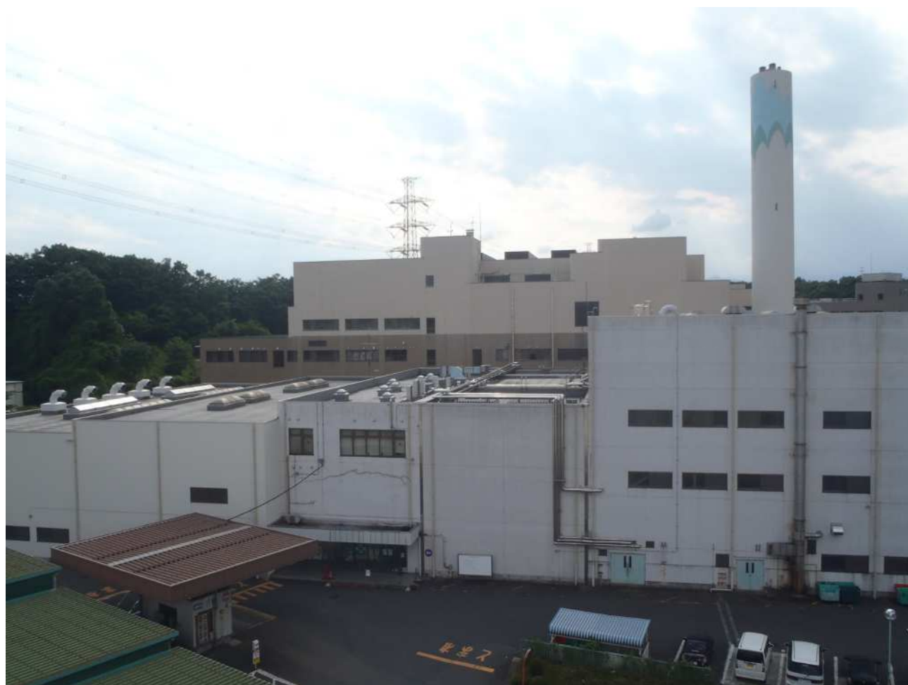
不燃物処理センター
