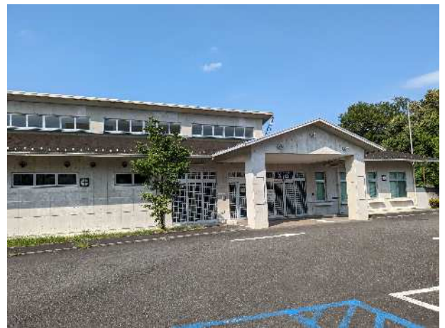
余熱利用施設「戸吹湯ったり館」
