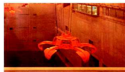
ごみクレーン
