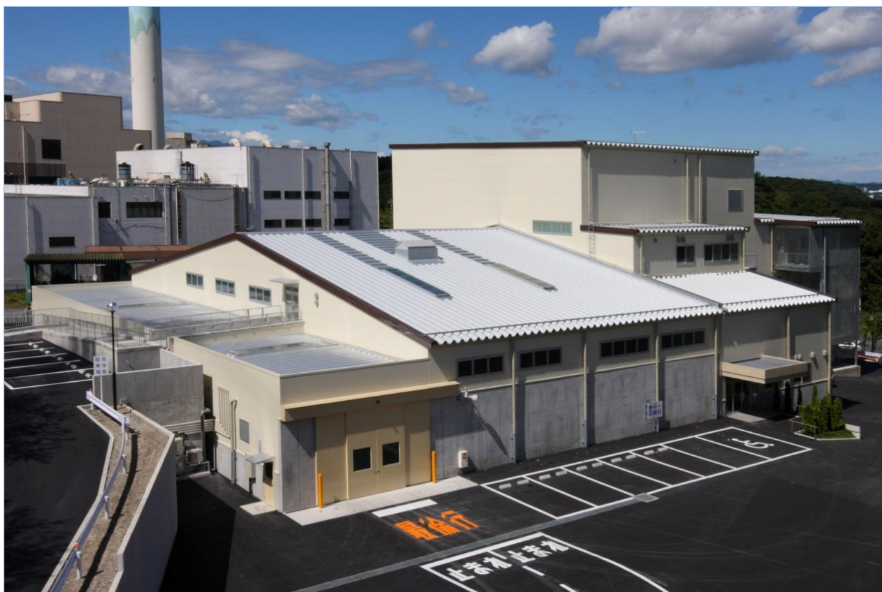
プラスチック資源化センター
