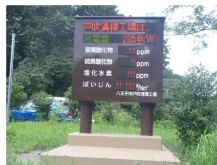
排ガス状況表示盤
