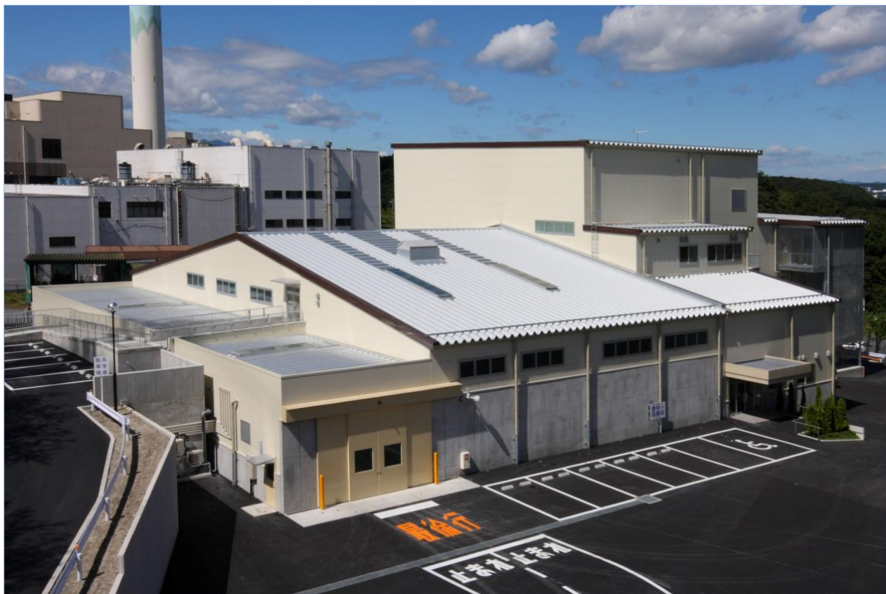
プラスチック資源化センター
