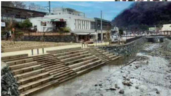
▲都が整備した階段護岸と調和した広場
