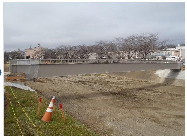
《完成した睦橋》
