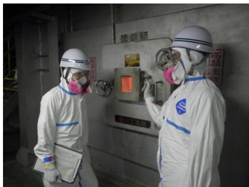
焼却設備日常点検体験
