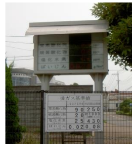
排ガス状況表示盤
