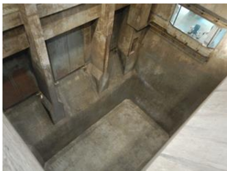
清掃後のごみピット
