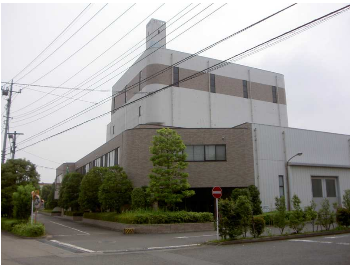
「北野清掃工場棟」
