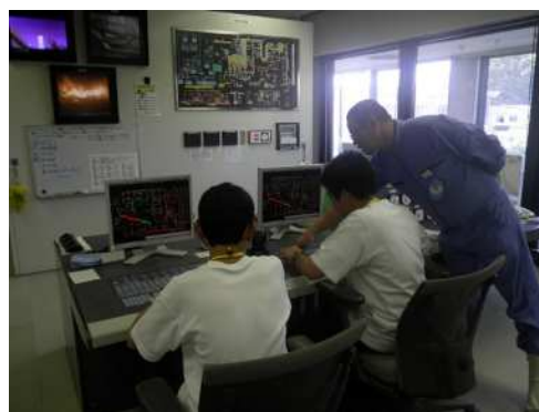
中央制御室での運転と見学対応の研修
