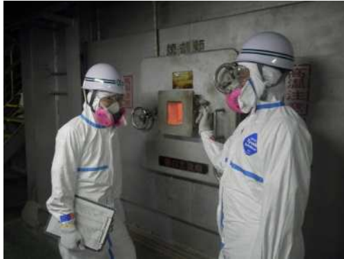
焼却設備日常点検体験
